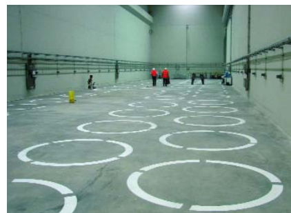
Castorstellplätze im Tunnel
