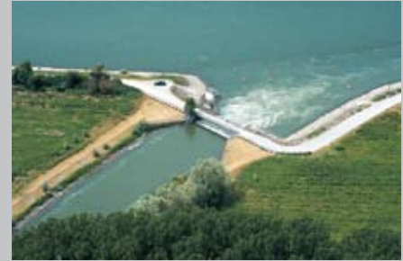
Rücklauf des gereinigten Kühlwassers in den Rhein
