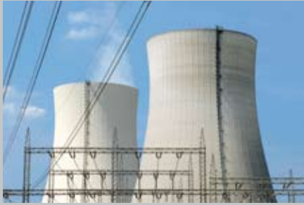
Kühltürme mit Freiluftschaltanlage
