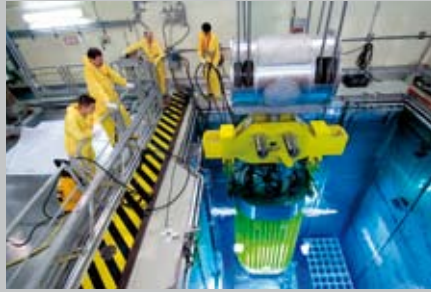
Brennelementtransfer ins Nasslager
