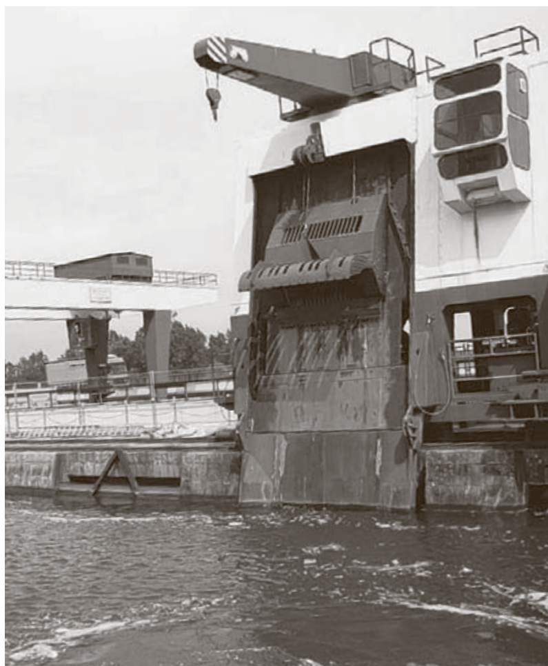
Unterricht am konkreten Objekt: Schüler des Überlinger Gymnasiums besuchen das Laufwasserkraftwerk in Iffezheim.
