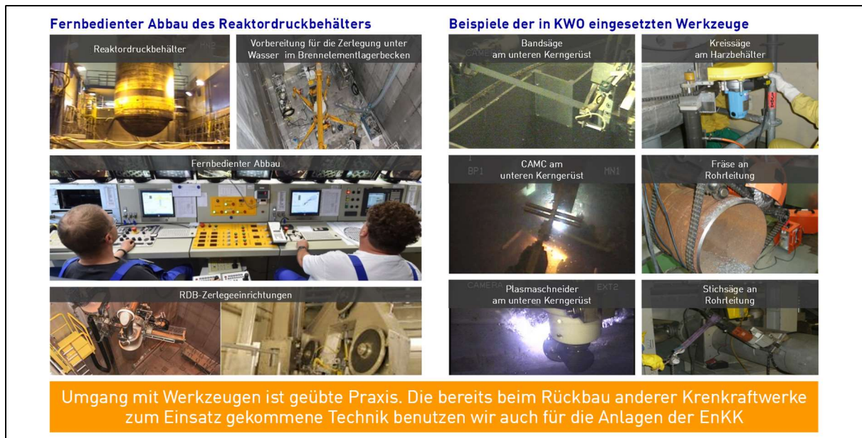
Abbildung 4: Beispiele für Zerlegetechniken beim Rückbau des Kernkraftwerks Obrigheim
