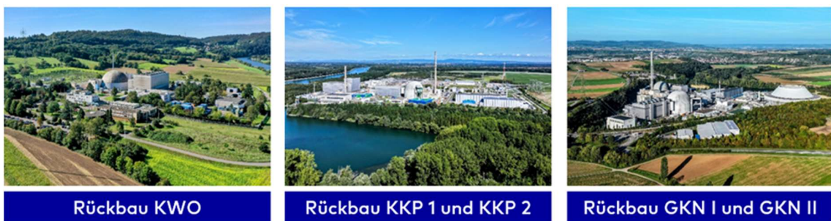
Abbildung 3: EnKK-Rückbauprojekte 2024 im Überblick
