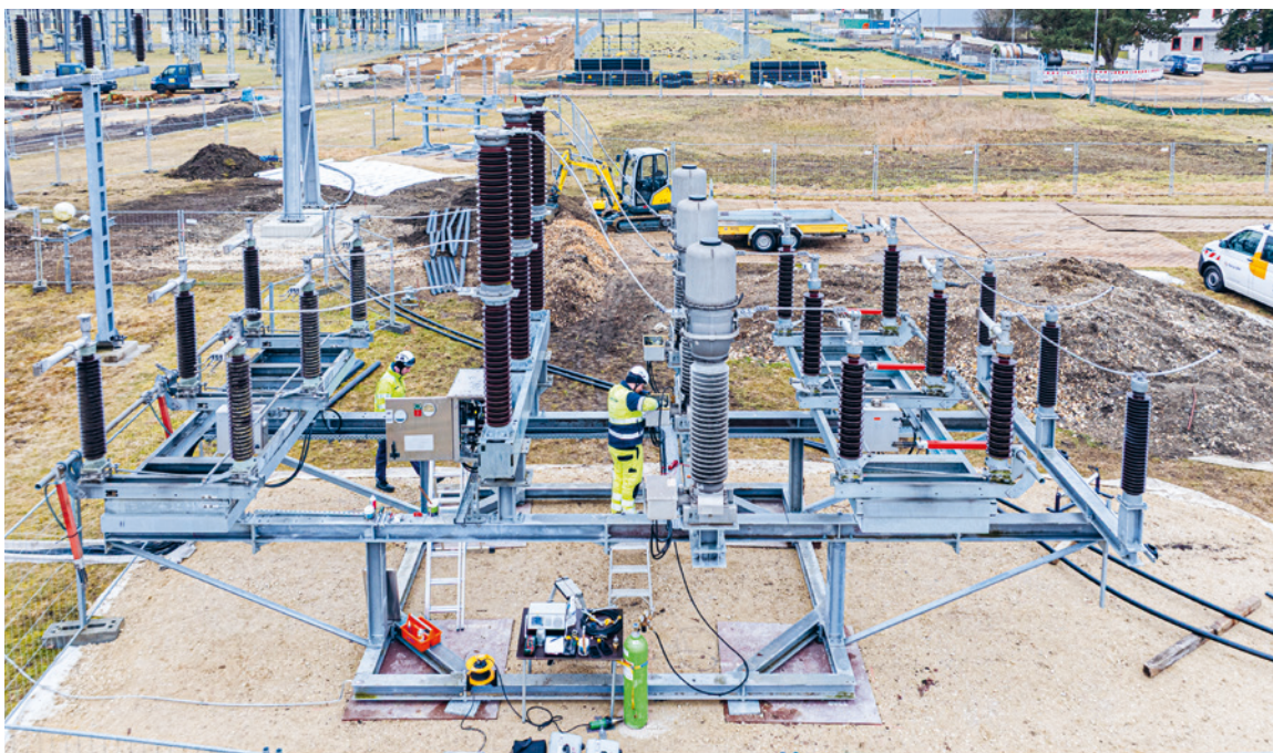
Experten bei der Arbeit: Um die Energiewende voranzutreiben, baut die Netze BW das Stromnetz in Baden-Württemberg pausenlos weiter aus. Anschläge durch Kriminelle sind bislang zum Glück ausgeblieben.
