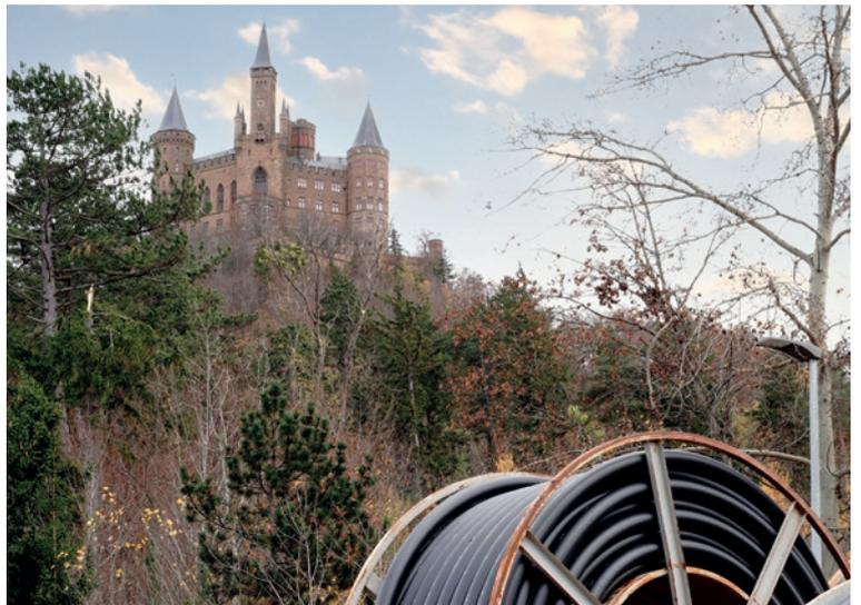
Ab unter die Erde: Die Kabelrollen am Fuß der Burg werden bald im Boden verlegt. Dabei wendet die Netze BW auf einer dicht bewachsenen Teilstrecke das schonende Spülbohrverfahren an. Die bisherige Freileitung musste ersetzt werden, da immer wieder Störungen auftraten.
