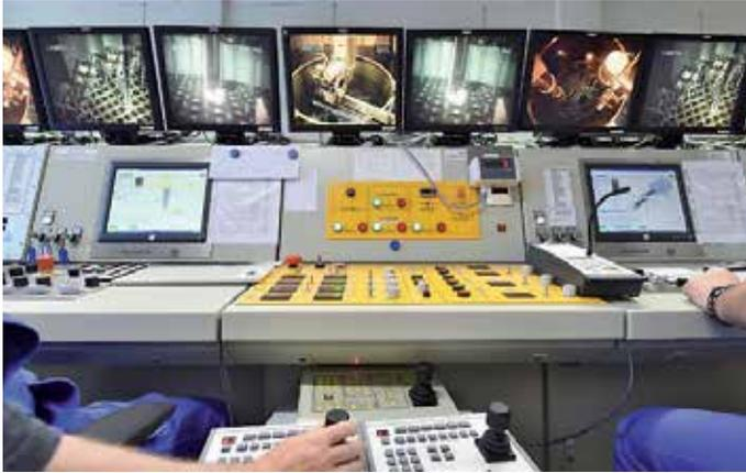
Die Rückbauarbeiten am Reaktordruckbehälter werden fernbedient ausgeführt.
