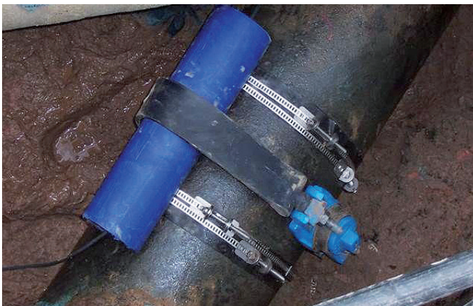
Sensoren an den Wasserrohren helfen Leckagen zu entdecken.
