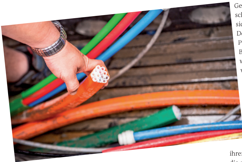
In diese Leerrohre werden Glasfasern eingeblasen.
