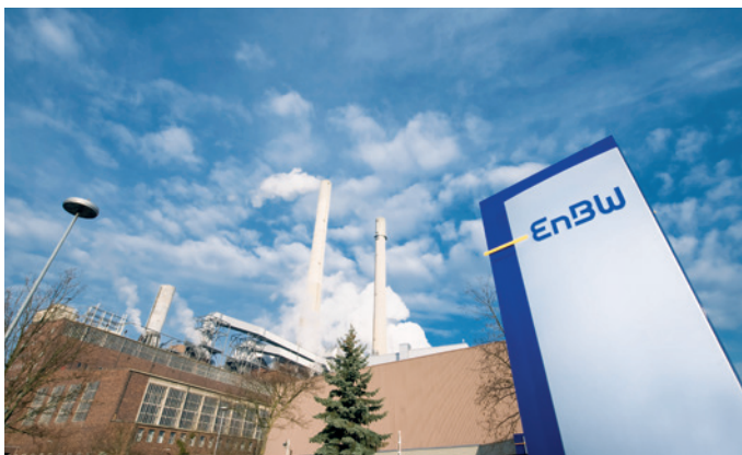
Der Heilbronner Stromspeicher besteht aus 768 Lithium-Ionen-Batteriemodulen, die sehr kurzfristig Energie zur Verfügung stellen können.
