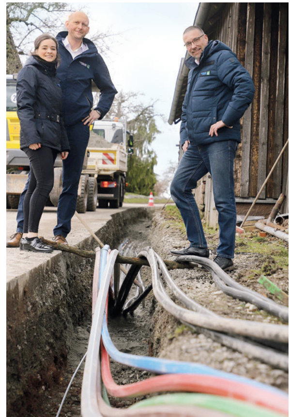
Baustellenbesuch: Infrastrukturdezernent Andreas Knörle (2. v. l.) und sein Breitband-Team vom Landkreis Calw.
