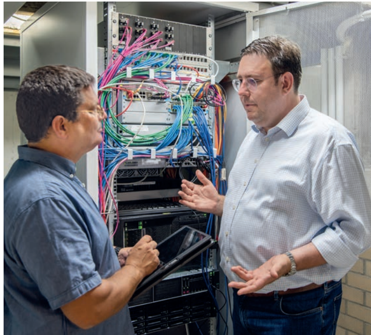
Verwaltungsleiter Axel Leute (r.) legt Wert darauf, dass die Schulen der Stadt auf die digitale Herausforderungen der Zukunft vorbereitet sind. Dazu zählt auch ein moderner Serverraum.
