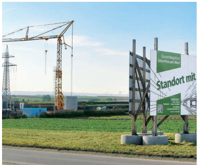
Das Konzept steht: Der künftige Gewerbepark nahe dem Stuttgarter Flughafen eignet sich auch für kleinere und mittlere Betriebe.
