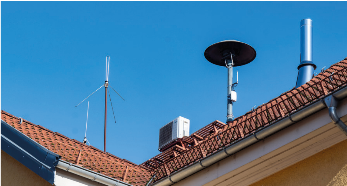
Die Daten des fernauslesbaren Wasserzählers werden über das Funknetz LoRaWAN versendet. Das dafür notwendige Gateway ist ein kleines Bauteil, das auf dem Rathausdach am Mast der Sirene angebracht wurde.
