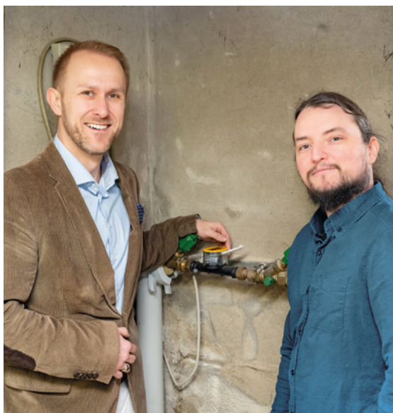
Auch im Keller des Bürgerhauses von Eschelbronn befindet sich ein fernauslesbarer Wasserzähler. Bürgermeister Marco Siesing (l.) erklärt die Funktionen gemeinsam mit Simon Maslowski vom Rechnungsamt.
