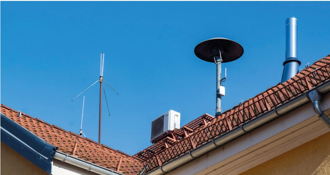
Die Daten des fernauslesbaren Wasserzählers werden über das Funknetz LoRaWAN versendet. Das dafür notwendige Gateway ist ein kleines Bauteil, das auf dem Rathausdach am Mast der Sirene angebracht wurde.
