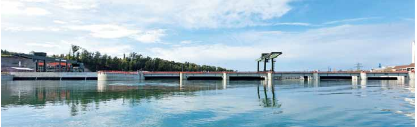
Hier im Laufwasserkraftwerk Rheinfelden am Hochrhein wird Strom für die Naturenergie der EnBW ODR erzeugt.
