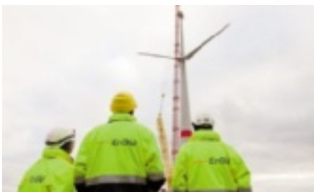
Beim Sternziehen werden die Rotorblätter an den Turm der Windanlage angebracht. Die Anlagen des Windparks in Berghülen im Alb-Donau-Kreis gehören mit einer Nabenhöhe von 138 Metern zu den derzeit höchsten in Baden-Württemberg.
