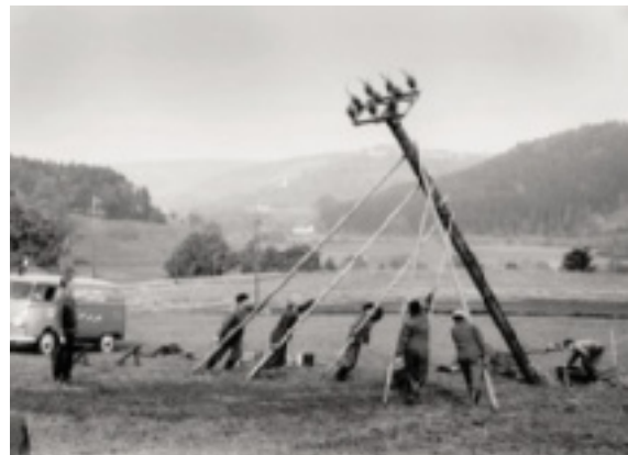
Kraftakt: Strommasten stellen im Jahr 1958 zwischen Rems und Ries, Hohenlohe und Donau.
