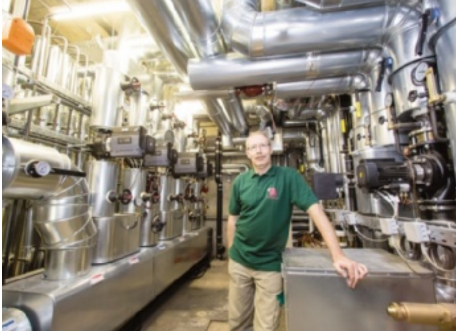
Der Technische Leiter der Wilhelma, Harald Meyer, hat den Überblick: Im Heizungsraum des Zoologisch-Botanischen Gartens wird die Fernwärme von der EnBW an die Wilhelma übergeben. Die Wärme wird dann in die einzelnen Bereiche des Zoologisch-Botanischen Gartens geleitet.
