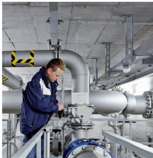
Experten der Netze BW kümmern sich um die Betriebssicherheit des Stuttgarter Trinkwassersystems.
