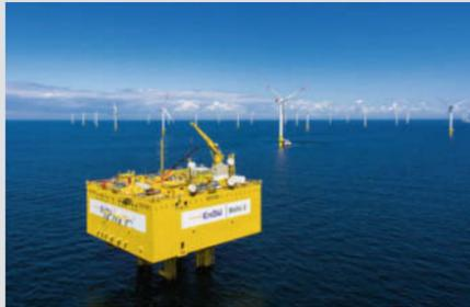
das Herzstück von EnBW Baltic 2. Um Übertragungsverluste gering zu halten und den Strom so effizient wie möglich an Land zu transportieren, wird dort die Spannung von 33 Kilovolt (kV; 1kV = 1.000 Volt) auf 150 Kilovolt transformiert. Anschließend gelangt der Strom mithilfe von zwei dicken Kabeln über den ersten Offshore-Windpark EnBW Baltic 1 zum nächsten Umspannwerk in Bentwisch bei Rostock. Dort wird die Spannung von 150 kV auf 380 kV transformiert und ins deutsche Verbundnetz eingespeist.
