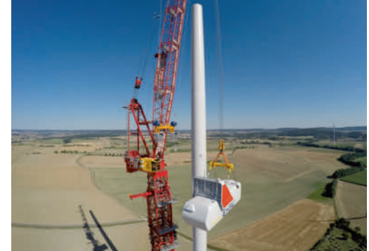
Der Windpark Rot am See in Hohenlohe im Entstehen: Hier drehen sich drei Anlagen des Typs Vestas V 126 mit einer Leistung von je 3,3 Megawatt (MW) und einem Rotordurchmesser von 126 Metern.
