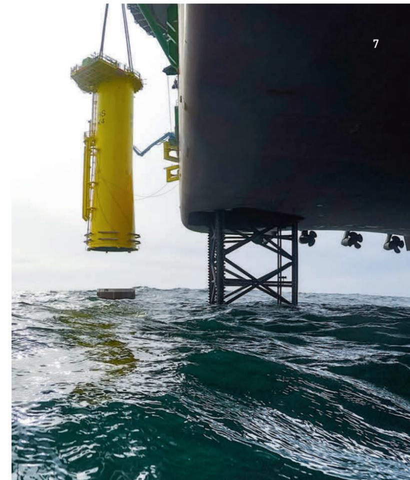
Millimeterarbeit auf hoher See: Diese beiden Teile (Transition Piece und Monopile) bilden zusammen das Fundament der Windkraftanlage.
