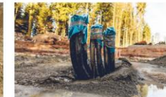
06 Bei der Verlegung der Kabeltrasse im offenen Verfahren wird ein Graben mit einer Tiefe von ca. 80 cm ausgehoben und die Leitungen in Sand eingebettet.
