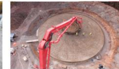
03 Beton wird eingebracht und nach Betriebsende wieder zurückgebaut.
