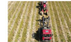
07 Die Verlegung der Kabeltrasse erfolgt, wo geologisch möglich, größtenteils mit einem gezogenen Kabelpflog.
