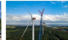
09 Die Errichtung der Windenergieanlagen beginnt.
