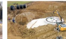
05 Mithilfe eines Baggers werden die Leitungen in die Leerrohre des Fundaments eingelegt.
