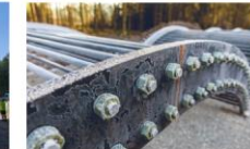
02 Das Bewehrungsgerüst wird erstellt.
