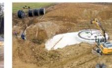
05 Mähle eines Baggers werden die Leitungen in die Leerröhre des Fundaments eingezogen.
