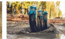
06 Bei der Verlegung der Kabeltrasse im offenen Verfahren wird ein Graben mit einer Tiefe von ca. 80 cm ausgehoben und die Leitungen in Sand eingebettet.
