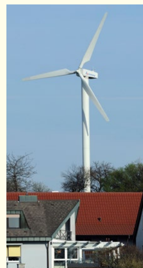
Auf ein verträgliches Nebeneinander von Windenergieanlagen und Wohngebäuden muss geachtet werden. So empfiehlt die Landesregierung für die Regional- und Bauleitplanung einen Vorsorgeabstand von 700 m zwischen Windenergieanlagen und Wohngebieten. Abweichend davon können sich in der Einzelfallbetrachtung deutlich höhere, aber auch niedrigere Abstände ergeben.
