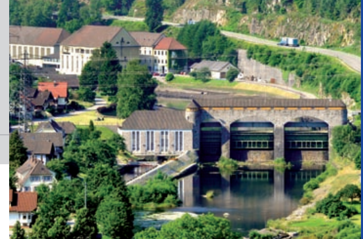
Ein in den Berg gearbeiteter Kavernenspeicher hätte keine Auswirkungen auf die Murg und wäre nach Abschluss der Bauarbeiten auch nicht zu sehen.
