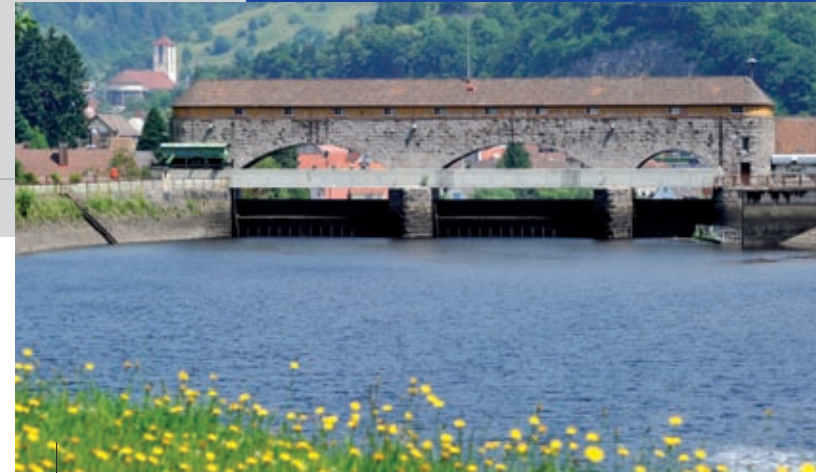
Die Stauanlage im unteren Bereich des Kraftwerks.
