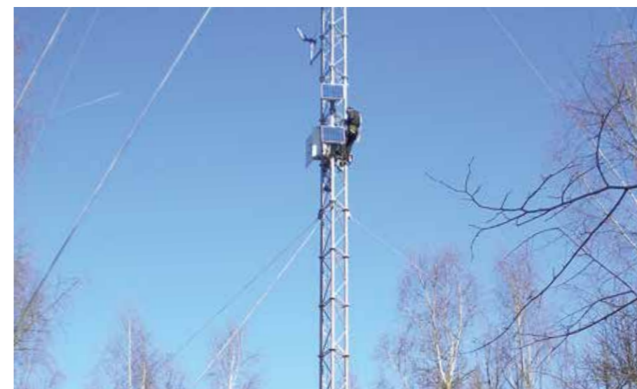
Der Windmessmast im Brüchlinger Wald liefert wichtige Erkenntnisse zur Eignung des Standorts
