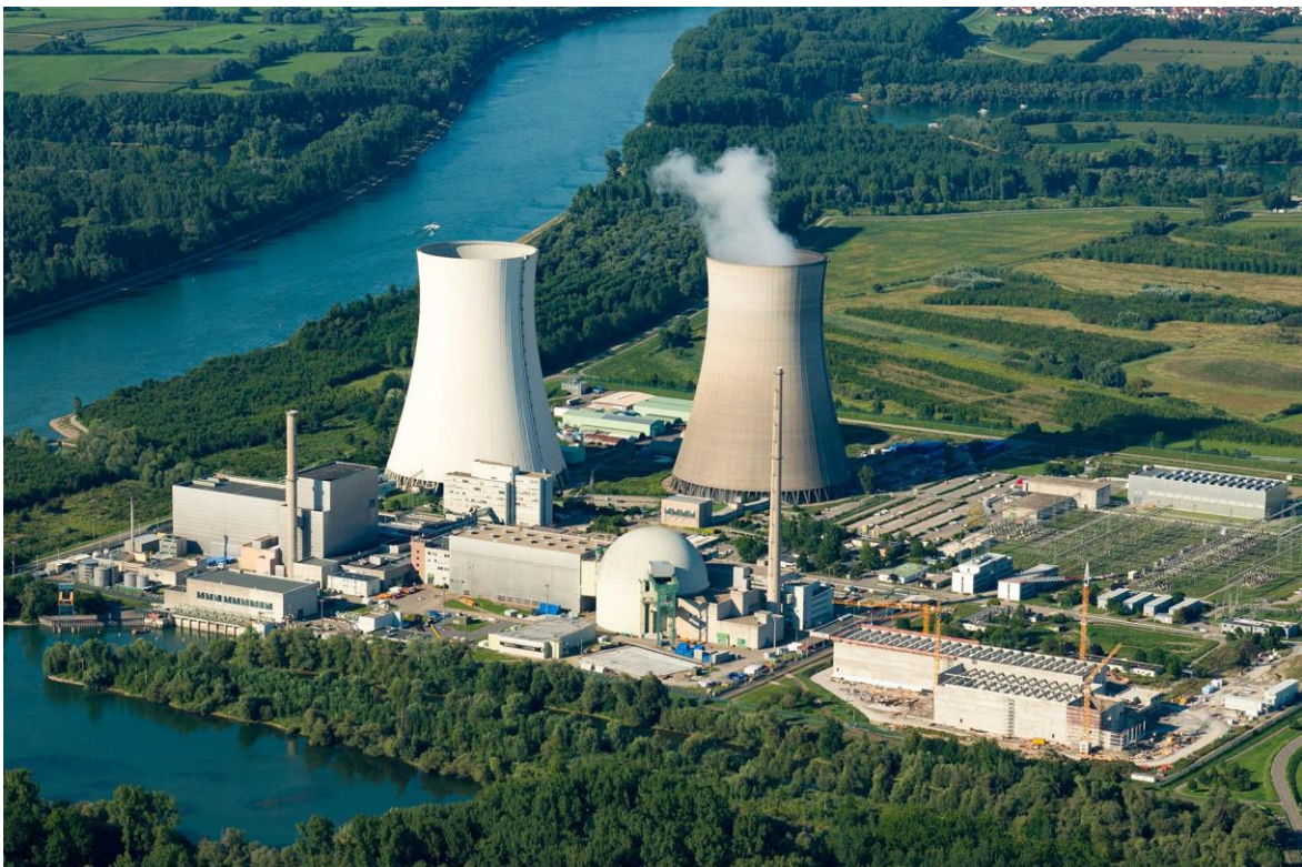
Der Standort Philippsburg: Im Vordergrund von links nach rechts Block KKP 1, Block KKP 2 sowie die sich im Bau befindliche Rückbauinfrastruktur (Reststoffbearbeitungszentrum, dahinter das Standort-Abfalllager). In der Mitte des rechten Bildrands ist das Standort-Zwischenlager zu sehen. Die Einmündung des Kühlwasserauslaufs in den Rhein kann man in der Mitte des linken Bildrands erkennen.
