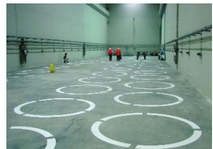
Castorstellplätze im Tunnel
