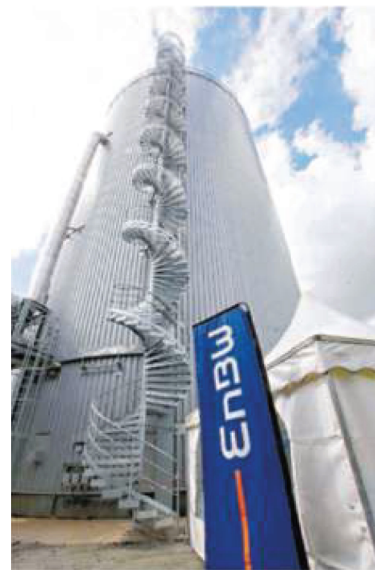
Das Gaskraftwerk verbessert die Luftqualität in Stuttgart.
