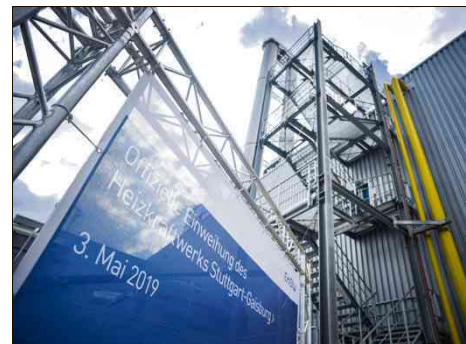
Das Kraftwerksgebäude ist 16 Meter hoch, das alte bis zu 60 Meter. Fotos: Lichtgut/Max Kovalenko
