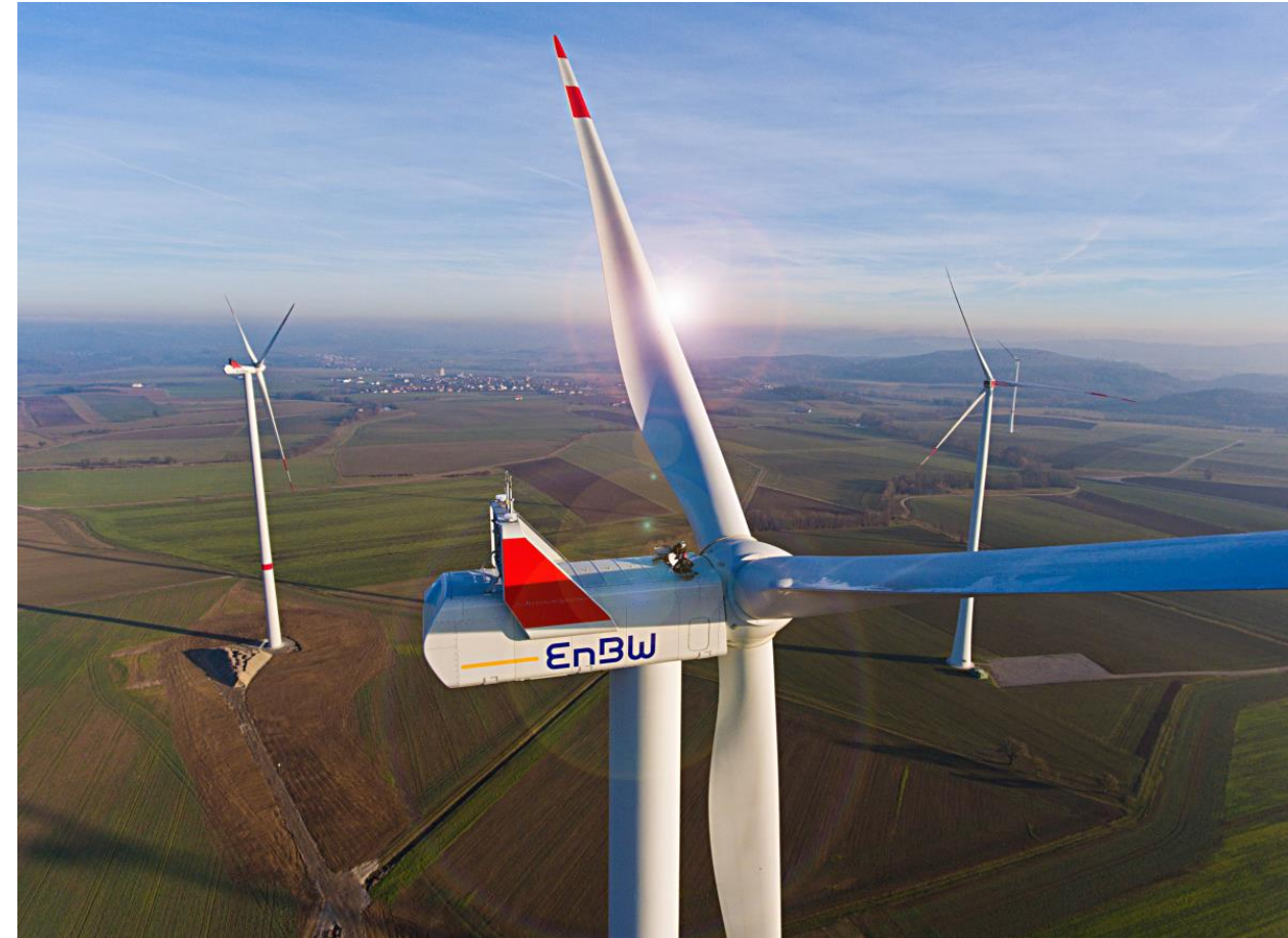
EnBW- Windpark Rot am See
