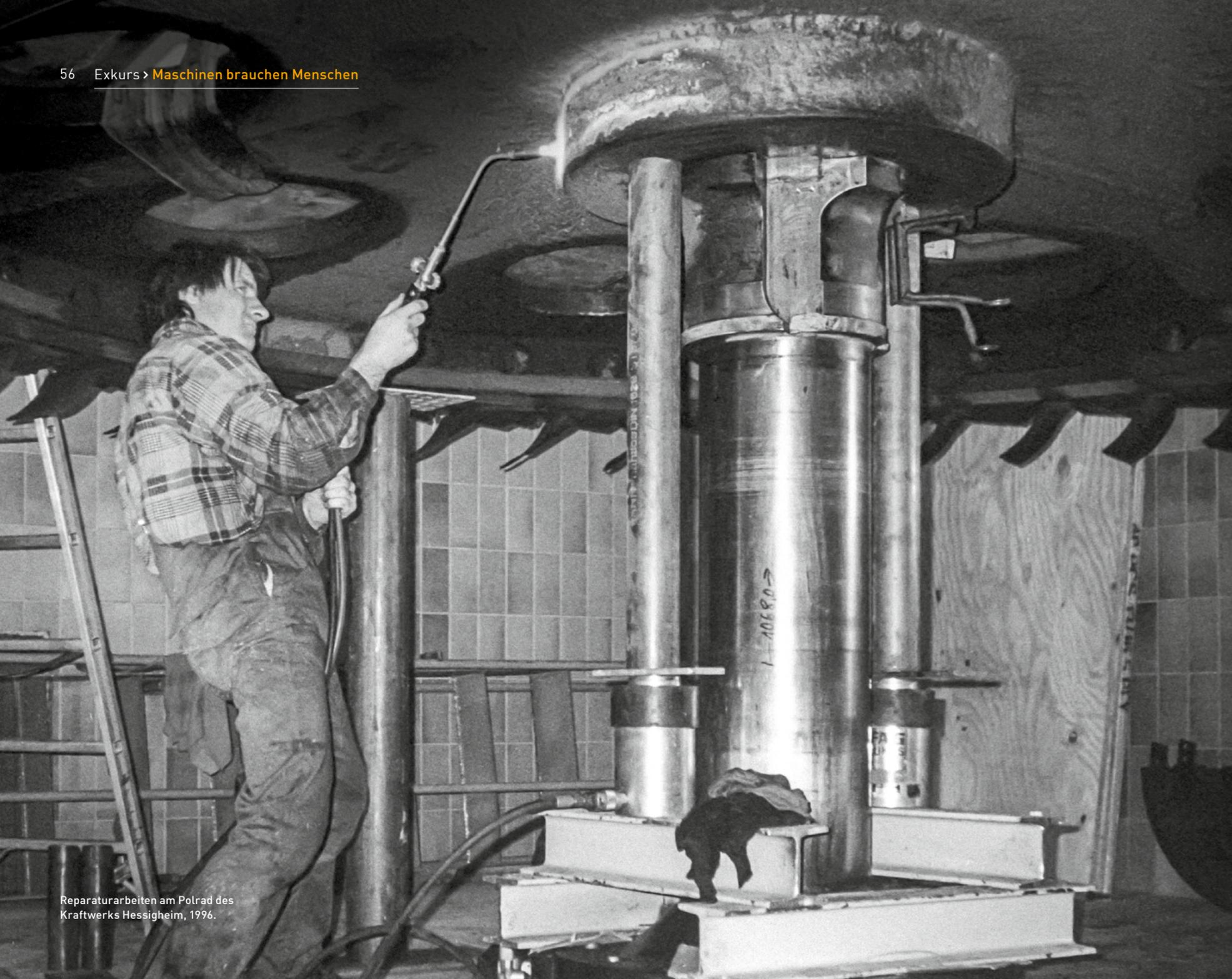
Reparaturarbeiten am Polrad des Kraftwerks Hessigheim, 1996.
