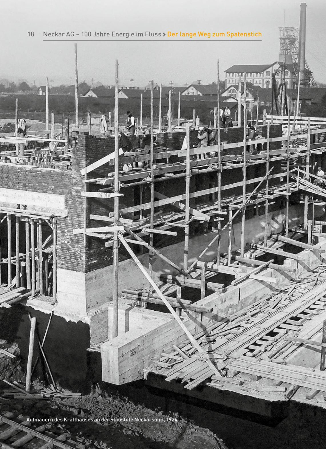
Aufmauern des Krafthauses an der Staustufe Neckarsulm, 1924.
