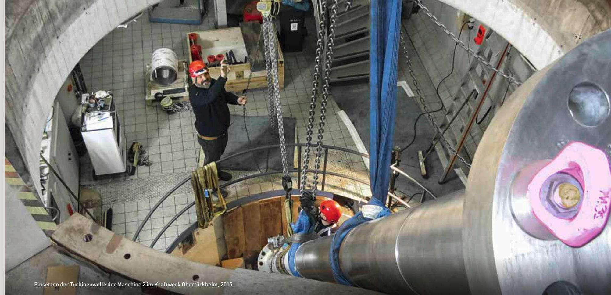
Einsetzen der Turbinenwelle der Maschine 2 im Kraftwerk Obertürkheim, 2015.
