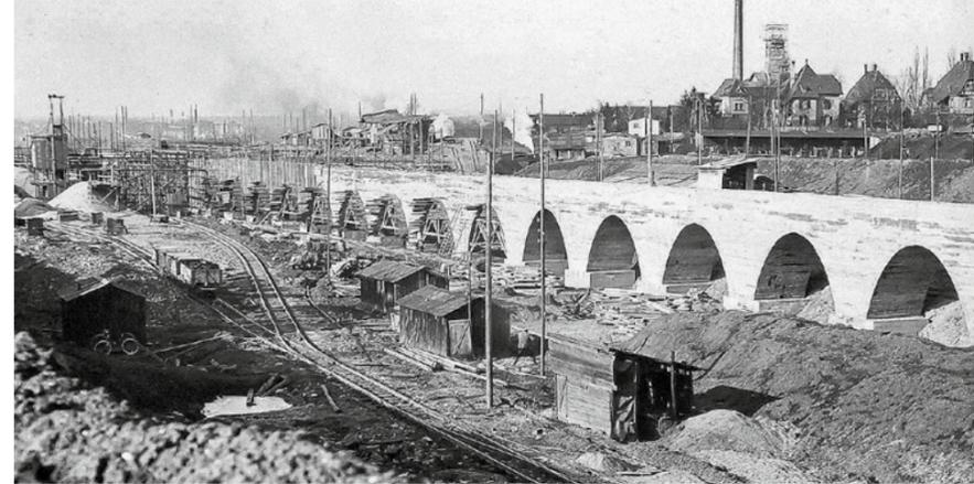
Betonierung der Leitmauer zwischen Schleuse und Kraftwerk der Staustufe Neckarsulm, 1924.
