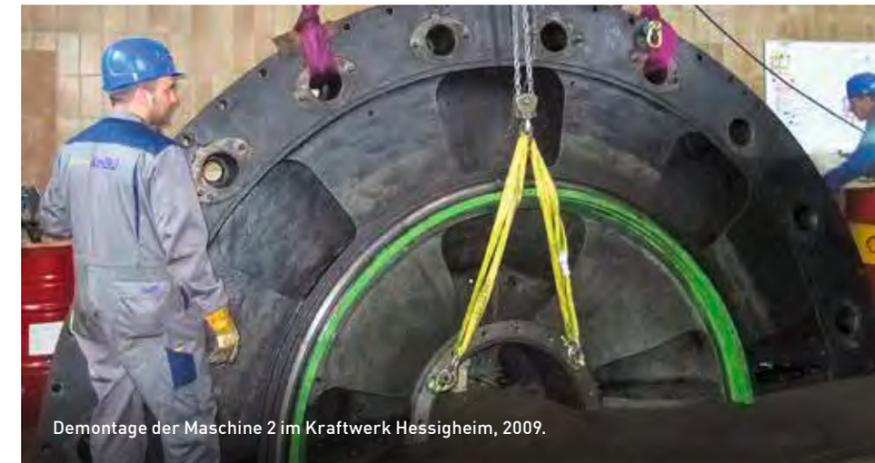
Demontage der Maschine 2 im Kraftwerk Hessigheim, 2009.
