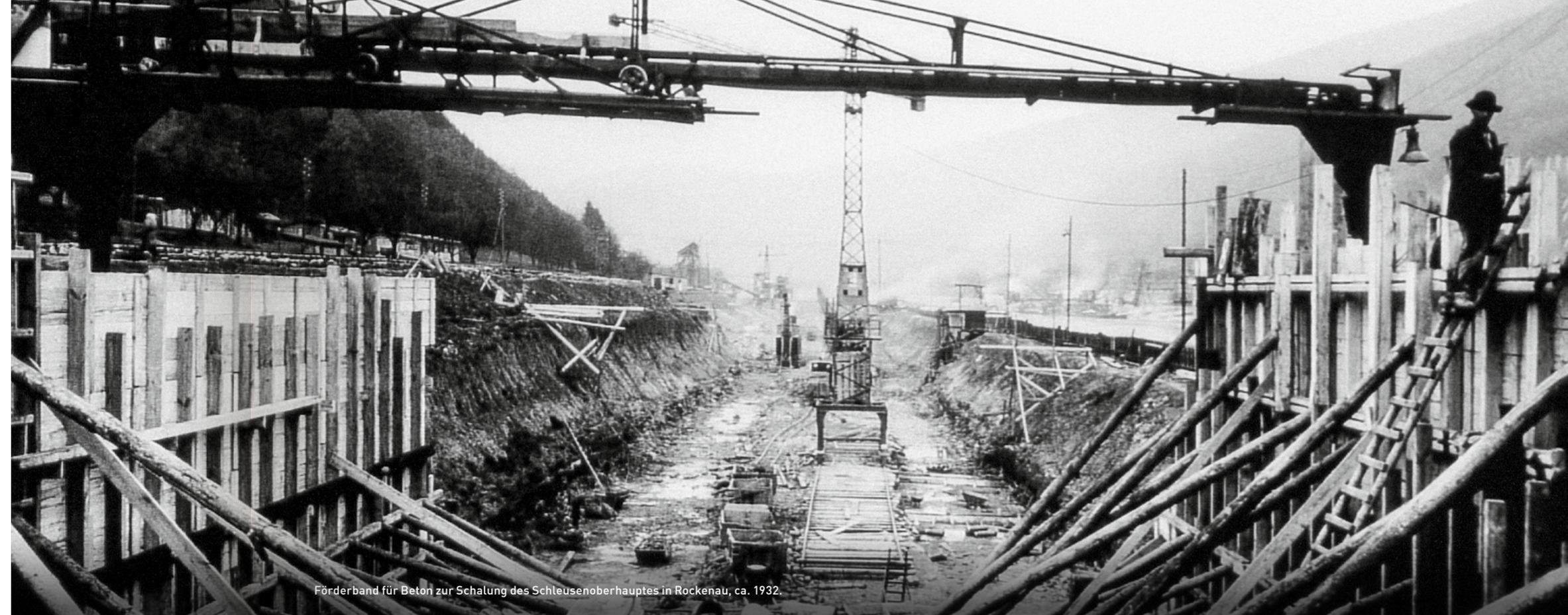
Förderband für Beton zur Schalung des Schleusenoberhauptes in Rockenau, ca. 1932.
