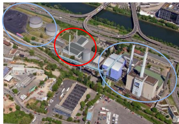
Bisherige Planung vom Mai 2015. Auf beiden Abbildungen sind die neuen Anlagen rot markiert, die bestehenden hellblau.
